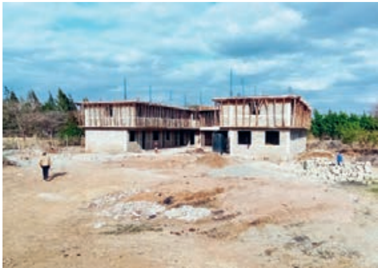
Der Rohbau des St. Josef Freinademetz Philosophiehaus
